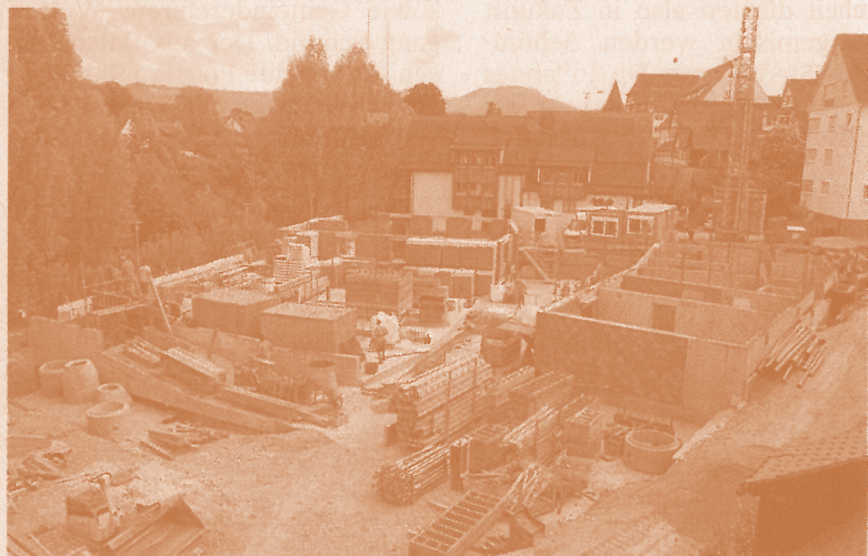
Die vier Gebäude am Mühltorplatz wachsen in die Höhe. Anfang 2018 sollen die 22 Wohnungen bezogen werden können. Foto: Thomas Godawa
